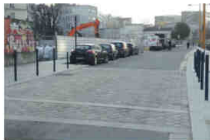
VÝVĚŽKA KŘIŽOVATKA - HORNÍ ČÁST V ASFALTU
