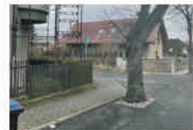
16. DOLÁZDĚNÍ AŽ KE KMEŇU STROMŮ
