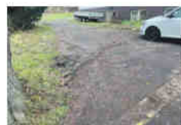
05 STROMY PŘED ŠKOLOU ZALTE DO ASFALTU
